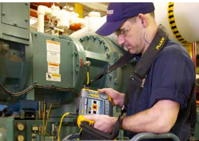
Das preisgekrönte Schwingungsmessgerät Fluke 810 verwendet ein automatisches Diagnoseprogramm, das Technikern hilft, effizient zu arbeiten.
