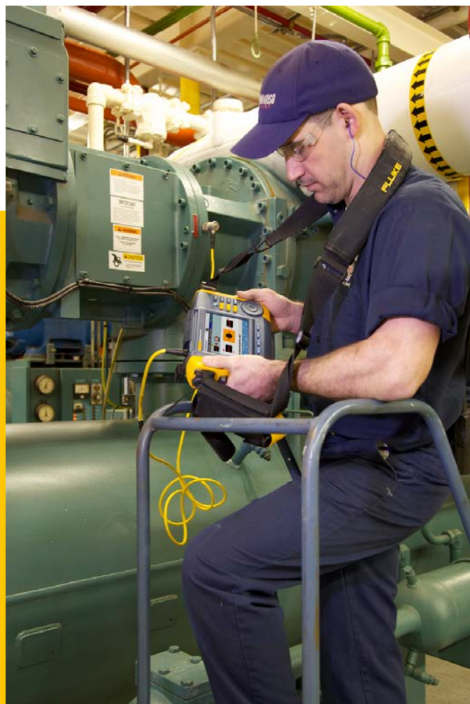
Alla Alpenrose Dairy, la regolare analisi delle vibrazioni fornisce i dati per l'analisi degli andamenti utilizzati nella manutenzione proattiva.
